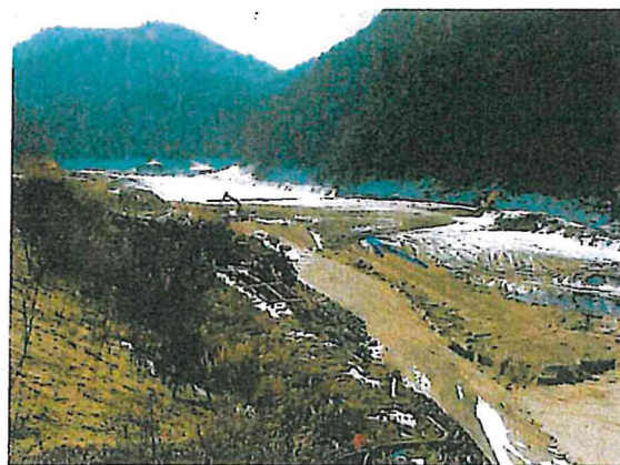
貯水池掘削状況(令和3年1月)
